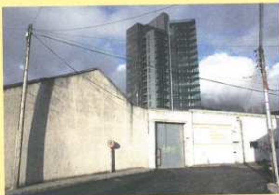
Des poteaux électriques en milieu urbain
