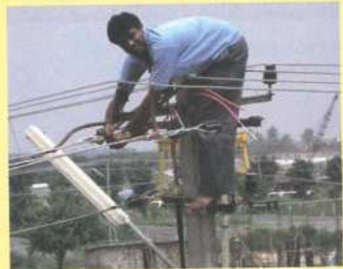
Travaux au sommet d'un poteau électrique
