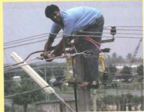
Travaux au sommet d'un poteau électrique
