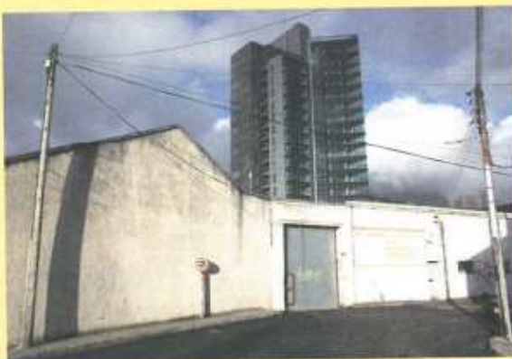
Des poteaux électriques en milieu urbain
